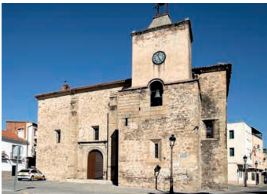
Fachada sur de la Iglesia de San Martín de Tours.
