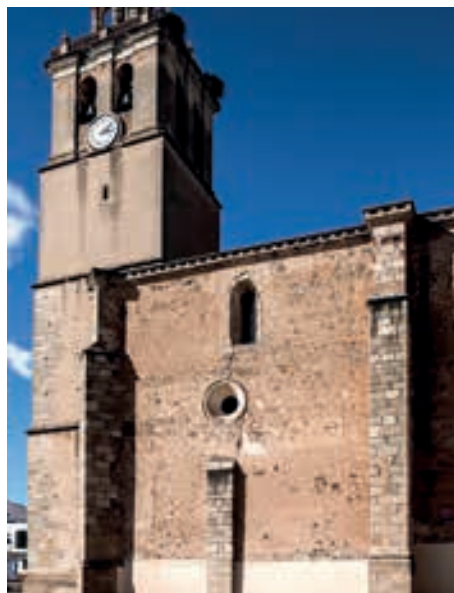
Reloj mecánico en la torre y reloj de sol (arriba a la derecha del contrafuerte menor).
