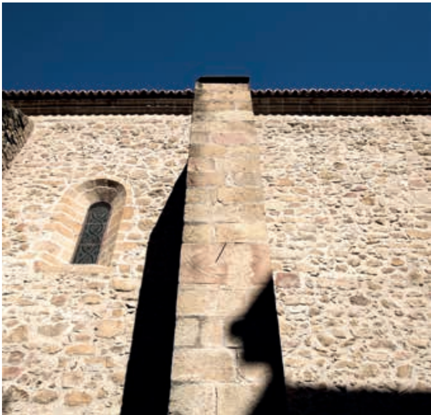
Contrafuerte de la fachada sur de la Iglesia de San Andrés con el reloj de sol.
