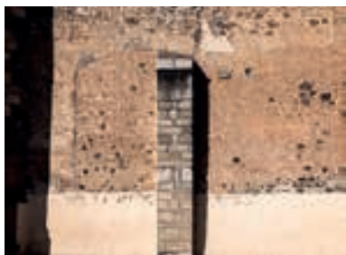
Detalle de los restos del reloj de sol (arriba a la derecha del contrafuerte).
