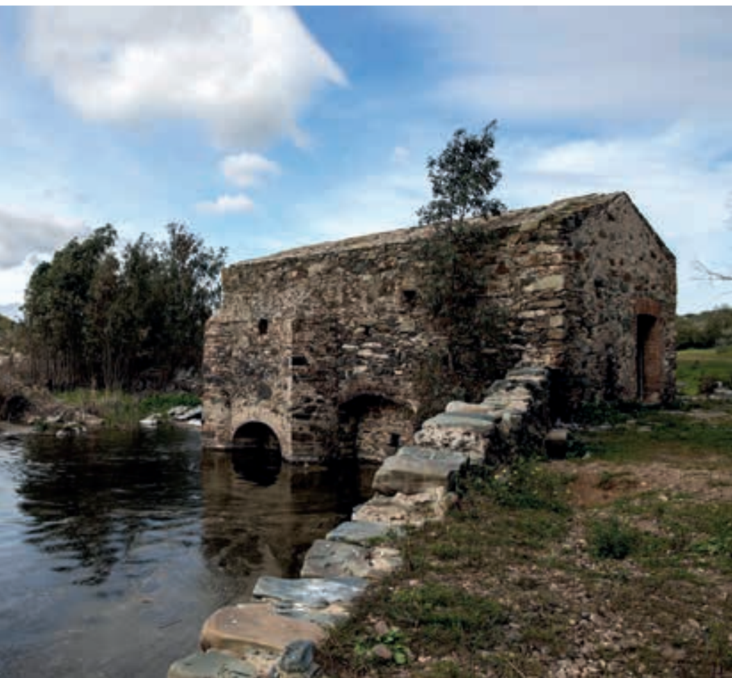
Molino de Malpica. Los tres relojes de sol están a la izquierda de la puerta del edificio.
