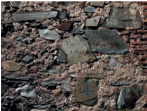
Detalle de los tres relojes de sol del molino de Malpica.
